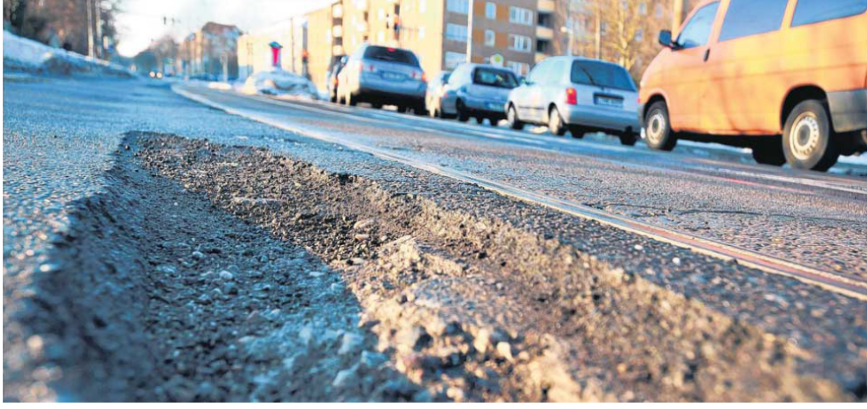
Der wegtauende Schnee macht die Schäden sichtbar: Wie in der Leipziger Richard-Lehmann-Straße hat der Winter viele Schlaglöcher hinterlassen.
